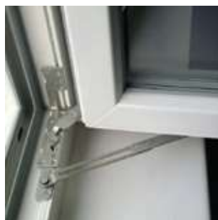
B-VB skrito nasadilo - spodaj verdeckt liegender Beschlag - unten cerniera a scomparsa - sopra
