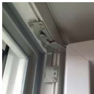
B-VB skrito nasadilo - zgoraj verdeckt liegender Beschlag - oben cerniera a scomparsa - sopra
